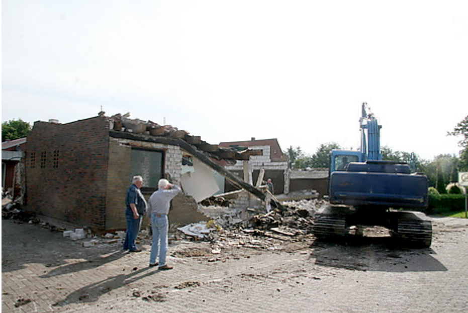
Ein Bagger machte das Gebäude dem Erdboden gleich.
